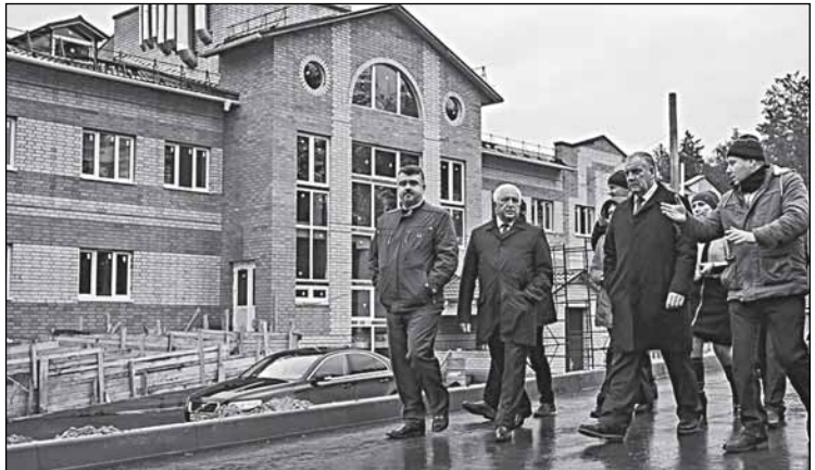
Любытино, поликлиника, стоимость общестроительных работ - 139,9 млн. руб.
